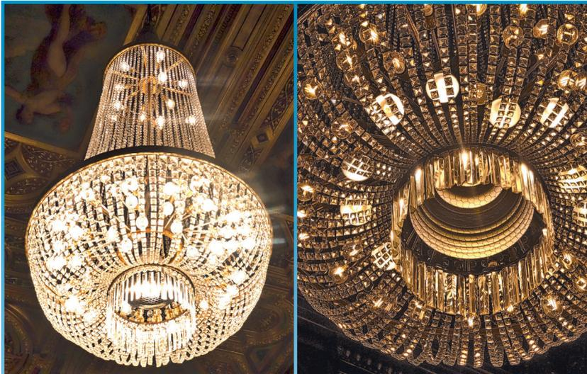
Fig. 1 - Cada um dos 10 lustres da sala combina lâmpadas de filamento LED de 3 W/6 W com módulos LED de 100 W.
